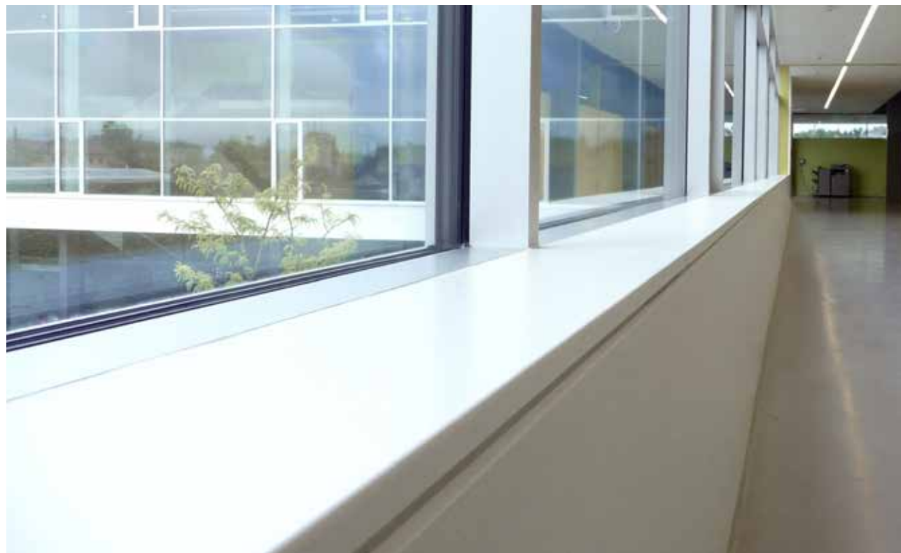
stumpfe Anbindung mit Anschlussprofil
